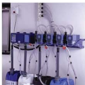
Turbo Pump – система дозирования для стиральных машин
